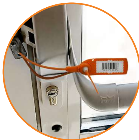
Дверь эвакуационного выхода
